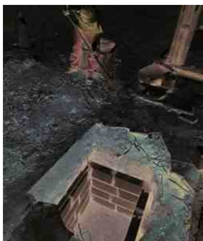
Construção de bocas de lobo.
